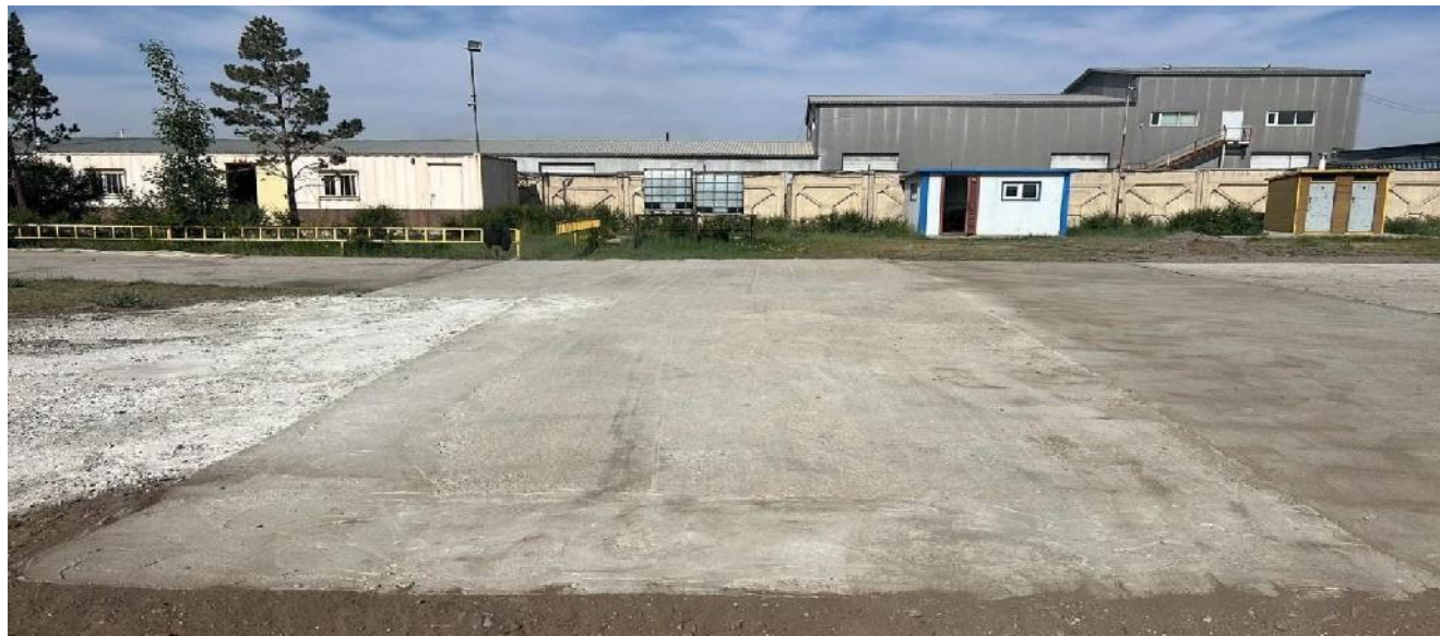
Зураг 14. Хөрс бетонжуулалт
